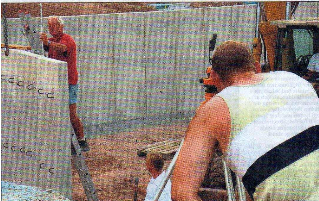
Auch ein Naturbad braucht Begrenzungen – „alles, was man später nicht mehr sieht“, sagt der Bürgermeister, wird im Moment auf der Baustelle für das neue Bad erledigt. FOTO: HEIKO MATZ
